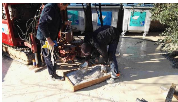
Zasipavanje bušotine do željene dubine za ugradnju piezometarske konstrukcije.
