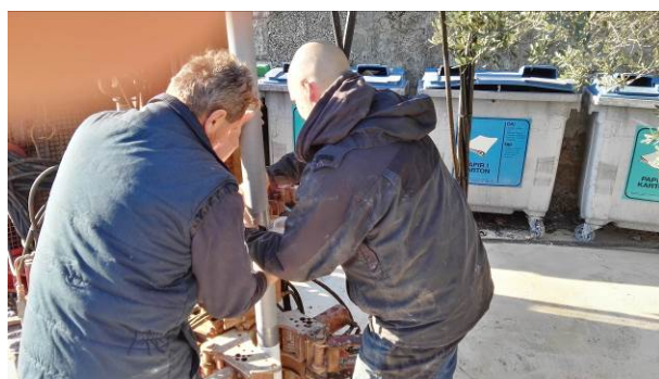
Ugradnja piezometarskih cijevi u izvedenu bušotinu S-123-16-15
