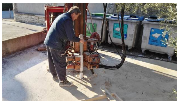
Ugradnja piezometrske cijevi unutarnjeg promjera 3" ( \phi \approx 76 mm).
