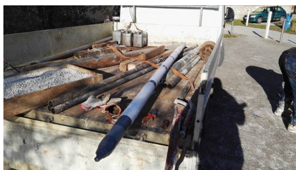
Taložnik sa čepom i filtarska dionica obložena geotekstilom i fiksirana samoljepljivom trakom.
